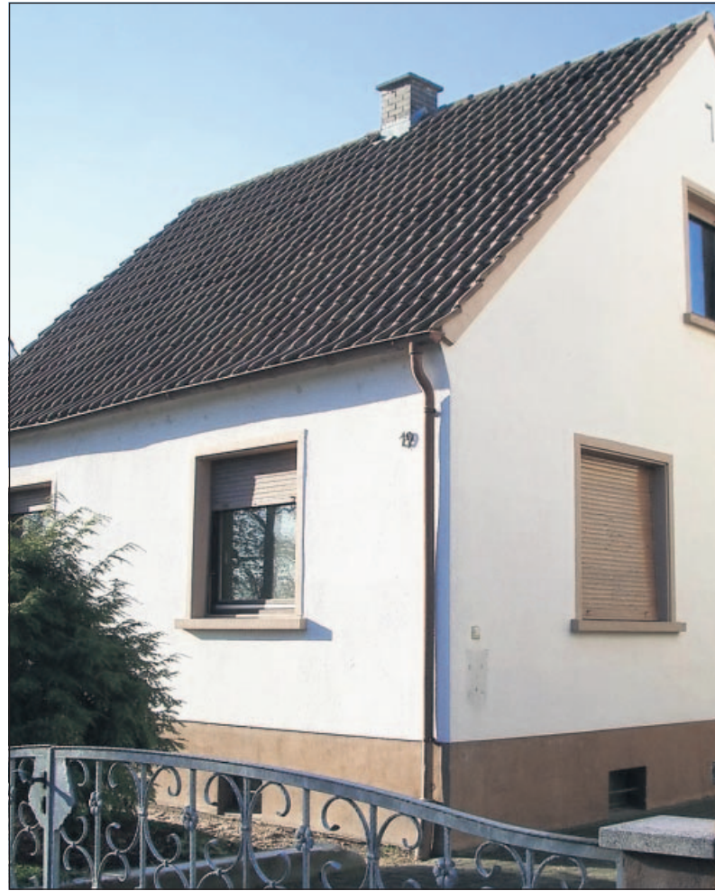
Ein und dasselbe Haus einst und jetzt: So wie auf dem linken Foto sah es vor dem Umbau aus. Der Kunde wollte den Wohnwert steigern. Das Objekt steht in Hört, wurde erweitert, modernisiert und energetisch saniert (Foto rechts).
