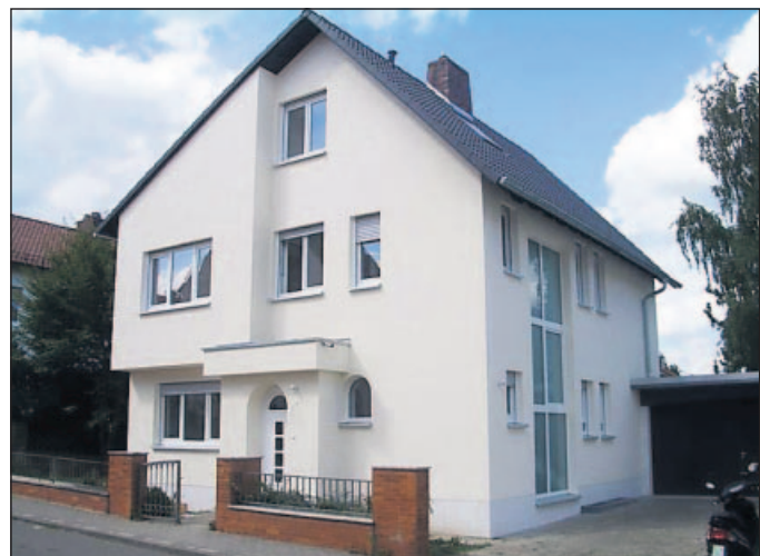
Aus Alt mach Neu: Das Einfamilienhaus in Wachenheim wurde von Doma saniert. FOTO: FREI
