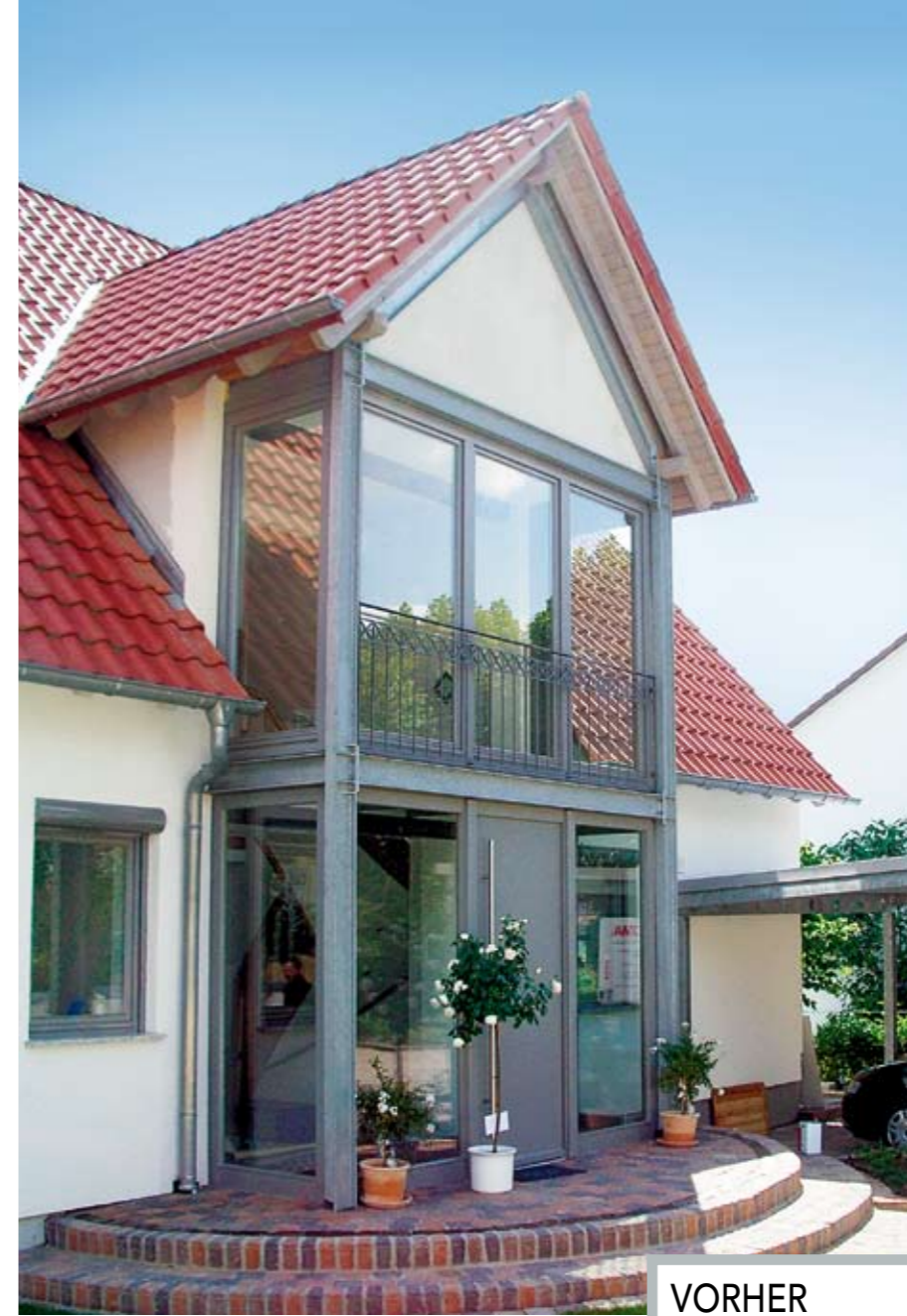
Nordansicht: Aus dem kleinen Eingangsbereich entwickelte der Architekt und Doma-Geschäftsführer Bernd Dollt ein großzügiges Entrée aus Stahl und Glas.
